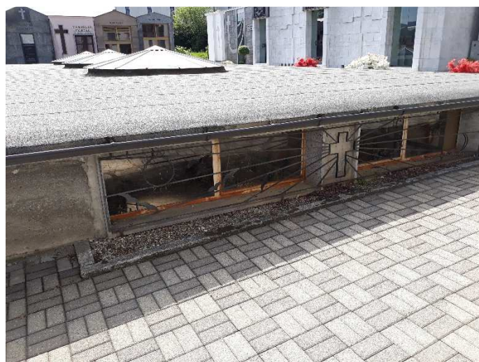
Foto 3 – Serramenti arrugginiti e guaina usurata
